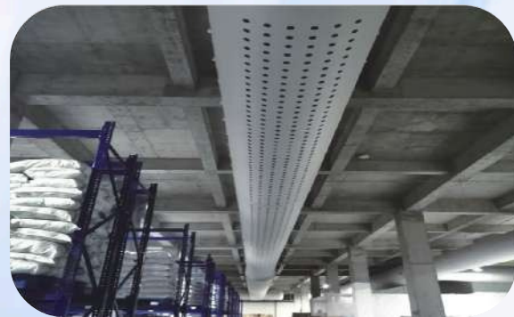
Anhui Xiehecheng Pharmaceutical Storehouse
